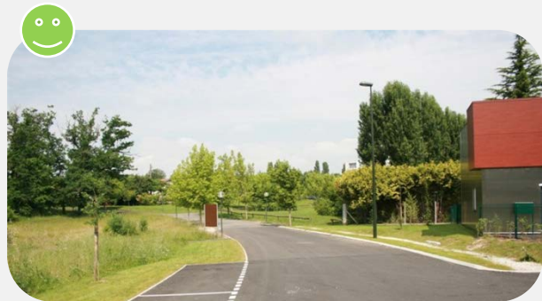
Un exemple de gestion superficielle des eaux pluviales
